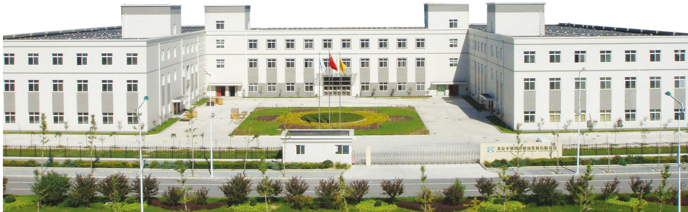
图 / 中关村科技园北京平和生产基地
